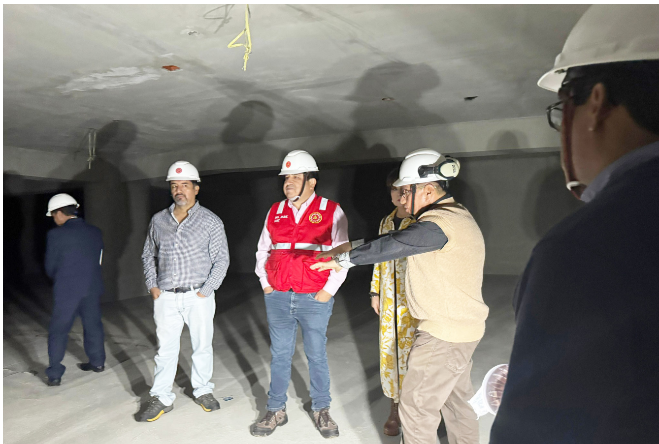
| Inspección de sótano del local institucional del CIP nuevo
