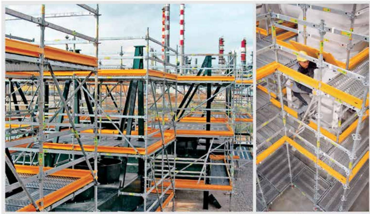
La nueva plataforma con trabe integrada permite fijarlas inmediatamente al colocarlas, para evitar que se levanten.
