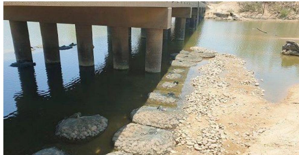
CONTROL DE SOCAVACIÓN
