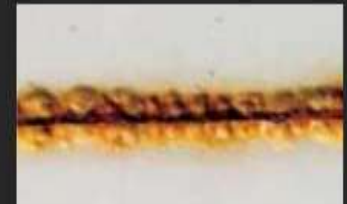
Pintura sobre acero não galvanizado
