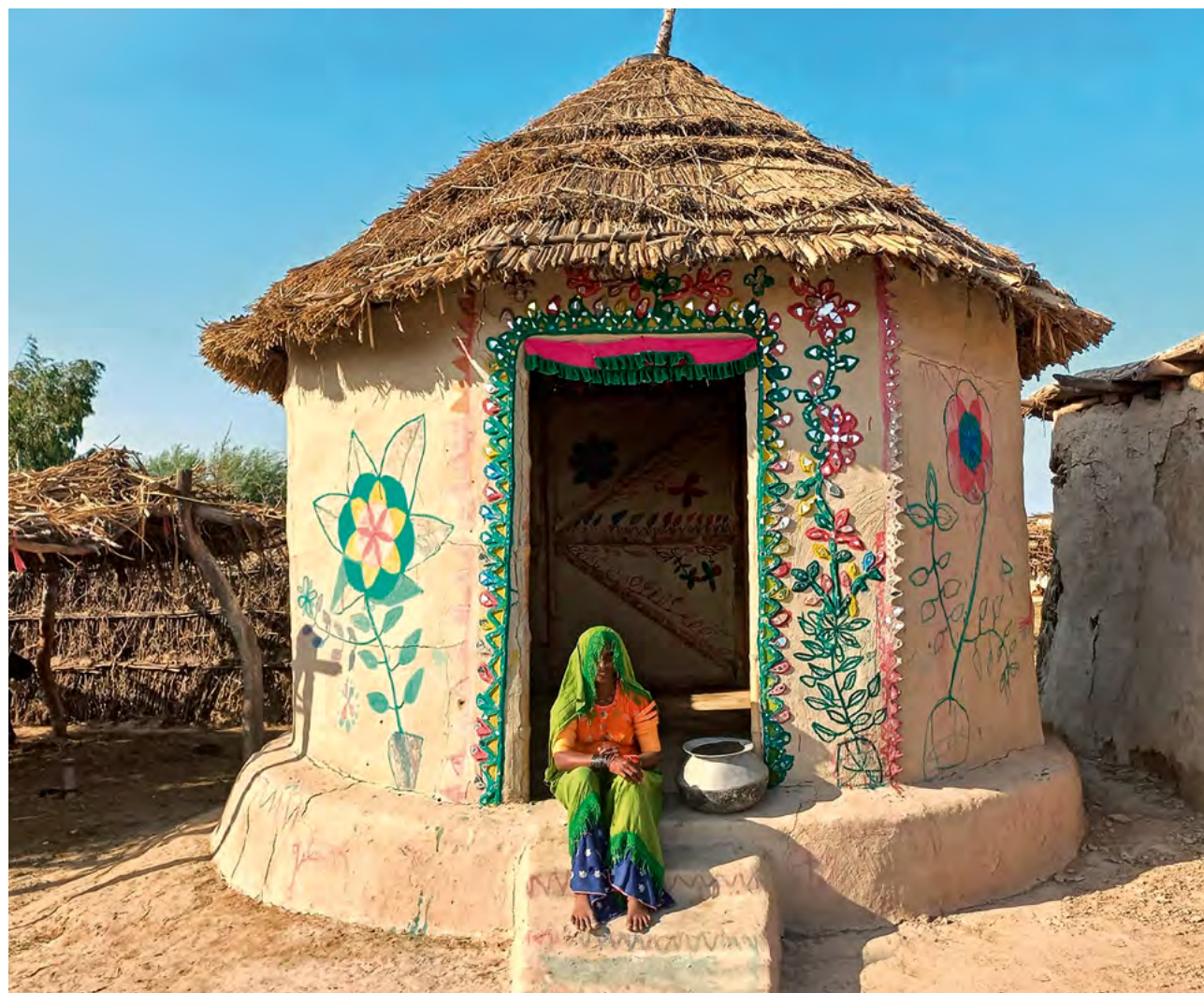
En el año 2011, Yasmeeen Lari construyó refugios de bambú cubiertos de barro en el espacio del Zero Carbon Cultural Centre, para ser utilizados como alojamiento para las personas que asisten a conferencias que se celebran en el centro comunitario.
