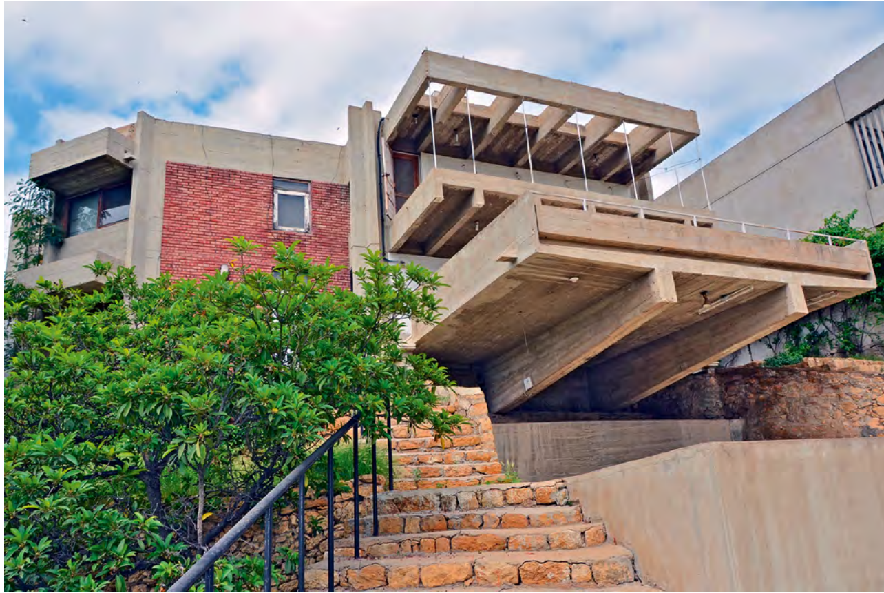
Mientras trabajaba en viviendas sociales, Lari también diseñaba para clientes privados casas y edificios de departamentos que introducían en Pakistán el estilo del «nuevo brutalismo» británico. Entre ellos, su propia residencia familiar: una estructura de concreto revestida de ladrillo y acentuada con dramáticos voladizos.
