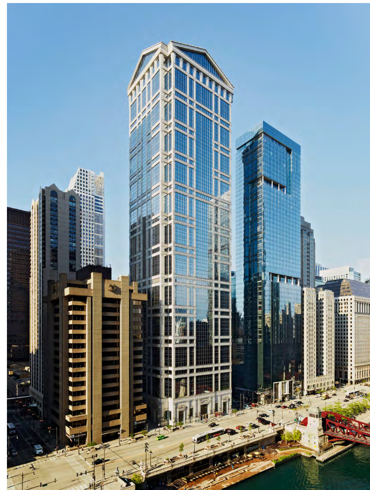
77 West Wacker Drive (1992) —un edificio de oficinas de cincuenta plantas en la orilla del río Chicago— representa un hito en la trayectoria del Taller de Arquitectura. El primer rascacielos construido por una oficina española en Estados Unidos destaca por su estilo clásico moderno, con granito blanco portugués y un muro cortina de vidrio gris plateado.
