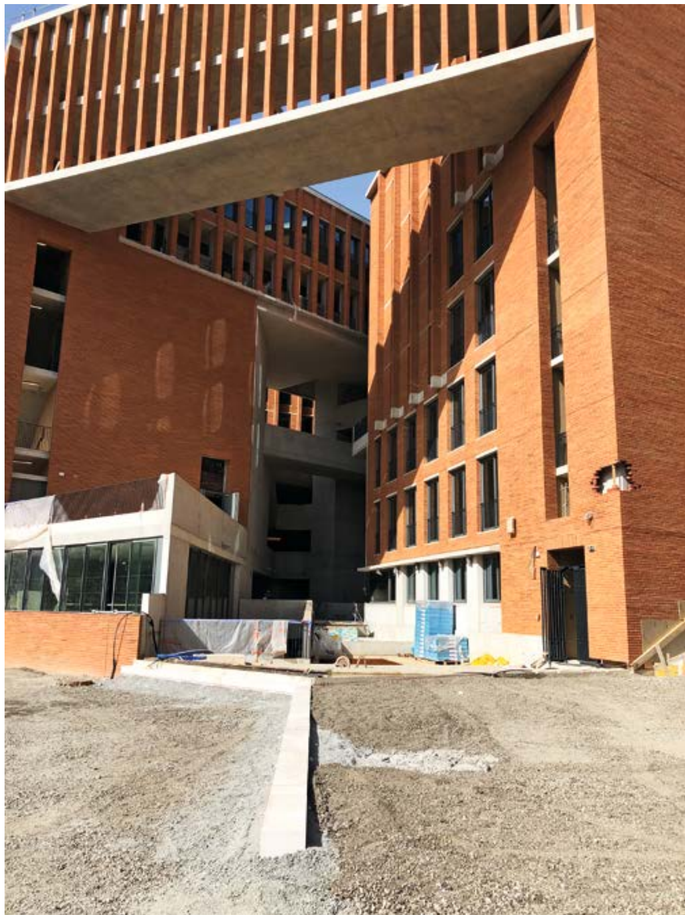
Entrada principal de la Facultad de Economía de la Universidad de Toulouse (2019). Foto: cortesía de Grafton Architects.
