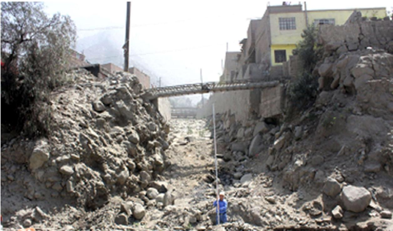
*Figura 1: Quebrada Rayito de Sol margen derecha: autor del artículo sujetando mira de 5 metros el día 27.07.2018, vista permite comparar dimensiones de detalles de la configuración próxima. Aguas arriba se visualizan muros parcialmente a ambos lados no llegando hasta la parte inferior cuyo ancho se reduce de 5 a 6 metros con altura (hasta tubo) inferior a 5 metros.*
