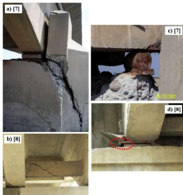
Figura 4. Daño estructural observado en el puente Huamaní luego del sismo de Pisco 2007 [7], [8]
