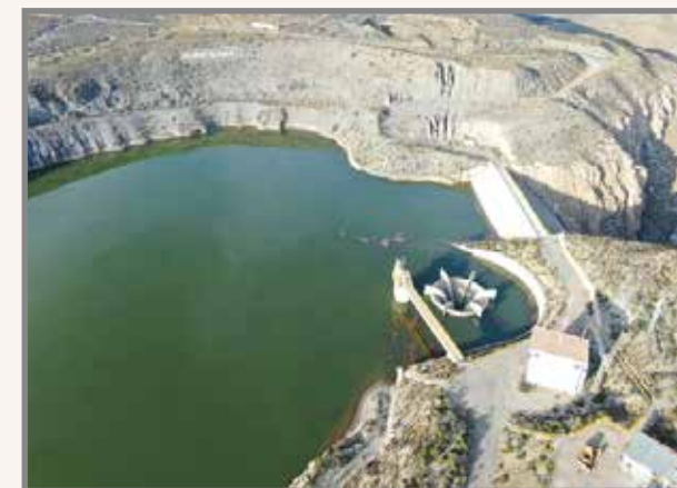
Estructura de descarga de la represa Aguada Blanca con floración algal. Fotografía: Marco Ríos.
