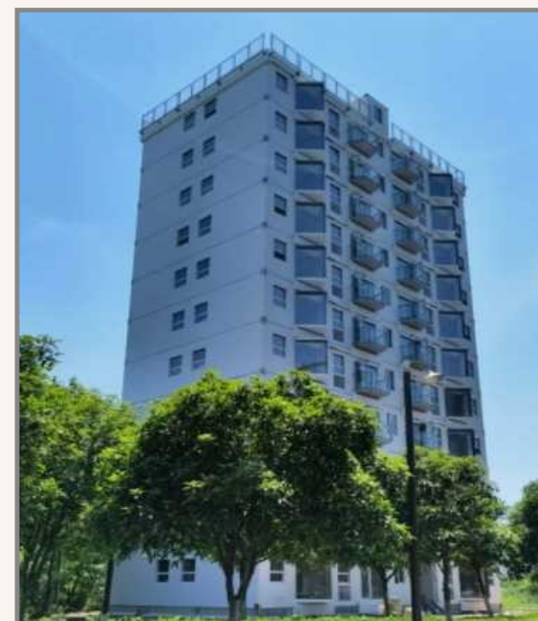
Figura 1: Junio del 2021, el grupo Broad de China ha construido (ensamblado) un edificio modular de diez pisos en 28 horas y 45 minutos, hazaña de construcción modular que bate récords de costo y tiempo.
