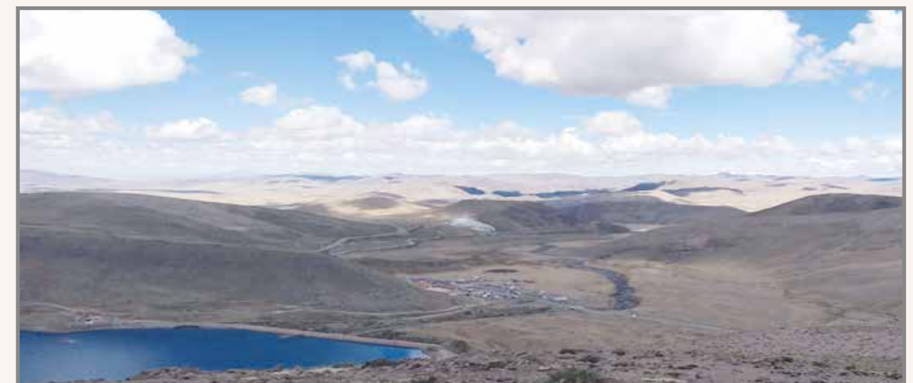
Represa El Pañe con vista aguas abajo. Fotografía: Albert Mamani.
