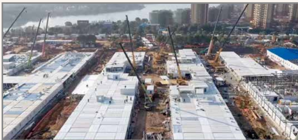
Figura 8: Construcción modular del Houshenshan Hospital en Wuhan - China en diez días, hazaña mundial de construcción modular, efectuado a raíz de la pandemia y, en adelante, nuestro modelo de productividad y gestión para proyectos modulares hospitalarios peruanos.
