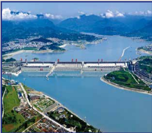
Presa de las Tres Gargantas, a orillas de la ciudad de Yichang, en la provincia de Hubei, en el centro de China.
