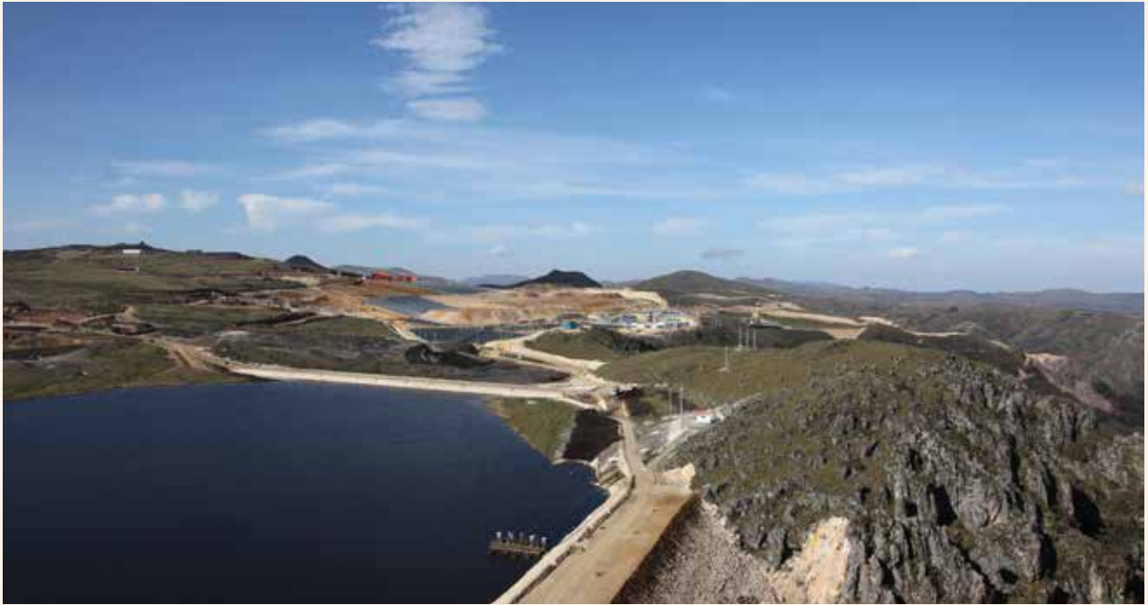
Presa Bramadero (La Zanja), Cajamarca.
