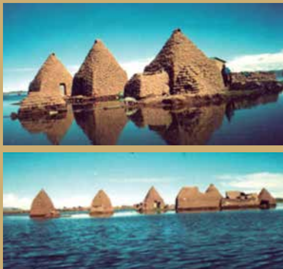
Figura 8: Grupo de Putucos construidos con ch'ampa, se puede apreciar la resistencia y estabilidad de la estructura a los efectos de la inundación del río Rámis en el 2003.
