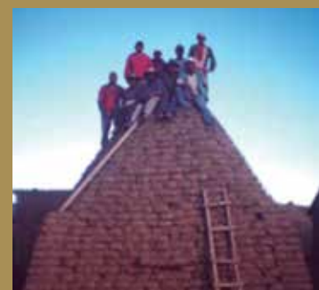
Figura 9: Se muestra un Putuco construido y concluido. Además, se puede observar que el techo se encuentra cargado de nueve personas cada uno con peso promedio de 70kg. (Imagen tomada del trabajo de G. Suaña; 2002).
