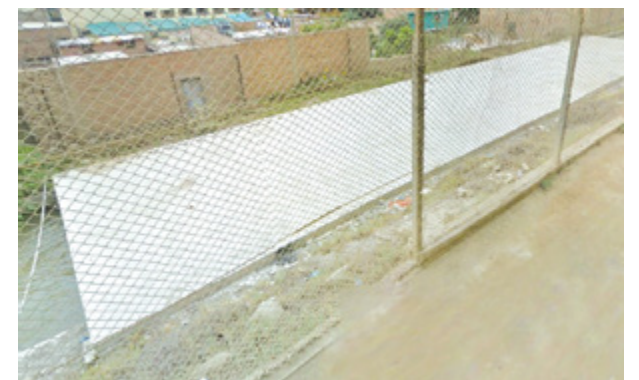
Tramo techado del canal
