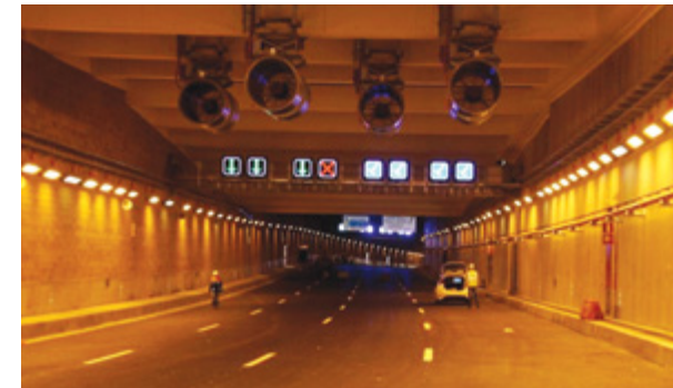
Fig. 9: Túnel de Benfica. Sistemas de seguridad y control instalados.
