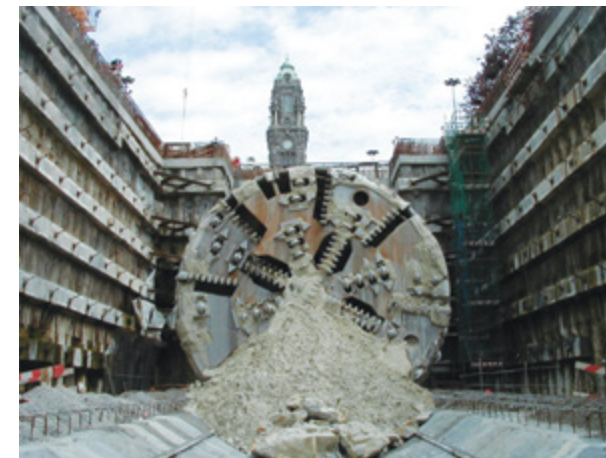
Fig. 12: Salida de la TBM en el recinto de la estación de Aliados, centro de la ciudad de Oporto.
