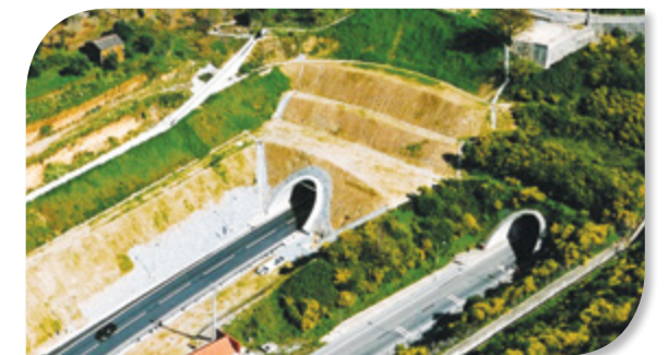
Fig. 3: Túnel de Gardunha I. Portal Norte. Instalación de sistema de impermeabilización y área de emergencia.
