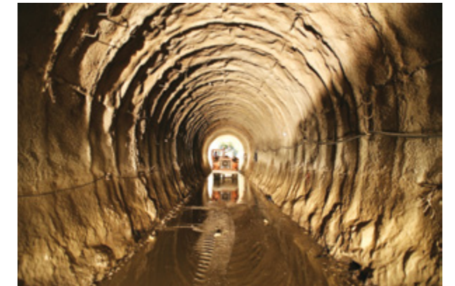
Fig. 14: Túnel de conexión entre las presas de Loureiro y Alvito. Sección de excavación y soporte primario.
