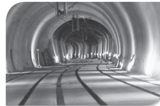
Fig. 2: Túnel de Pragal. Obra civil concluida.
