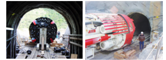
Fig. 13: Túnel de conexión entre los reservorios de las presas de Odelouca y Funcho. Montaje de la máquina TBM.
