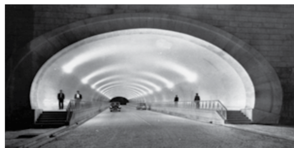
Fig. 8: Túnel de la Ribeira do Oporto. Construcción del revestimiento definitivo (1949) e túnel terminado (1952).
