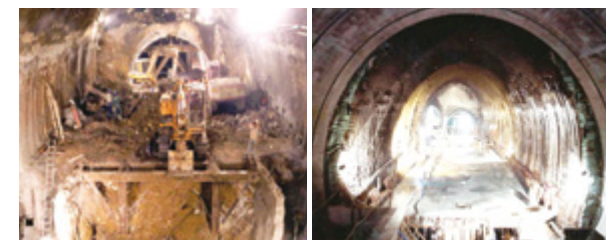
Fig. 11: Metropolitano de Lisboa. Estación de Baixa-Chiado. Fases de construcción.
