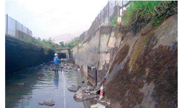
Verificación de la altura y secciones del canal
