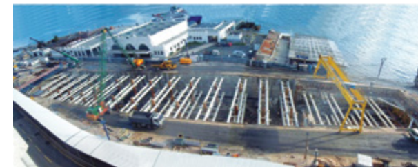
Fig. 10: Metropolitano de Lisboa. Vista de la estación de Terreiro do Paço. Sistema de apuntalamiento de la excavación. Atrás: la estación fluvial sobre el río Tajo.
