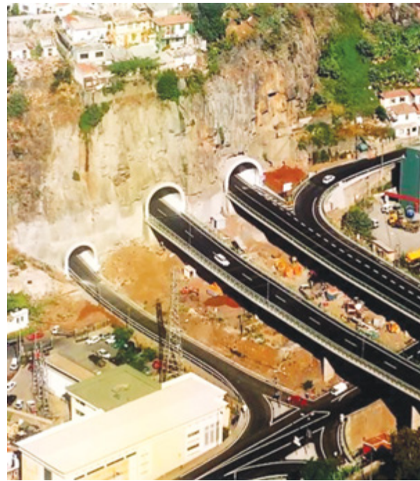
Fig. 7: Nodo del valle de Ribeira de Santa Luzia. Portales y ligaciones viales de los túneles João Abel de Freitas y el del ramal de salida Sur.
