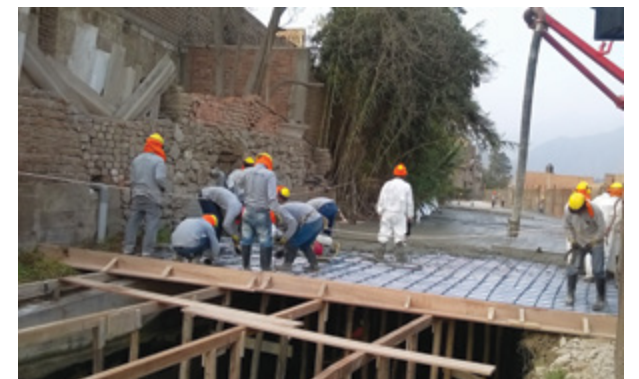
Vaciado de concreto en el canal
