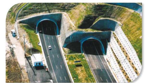
Fig. 4: Túnel de Mato Forte.
