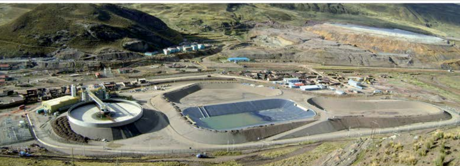
EPC PLANTA DE TRATAMIENTO DE AGUAS ÁCIDAS DEL TÚNEL KINGSMILL, YAULI, JUNÍN
