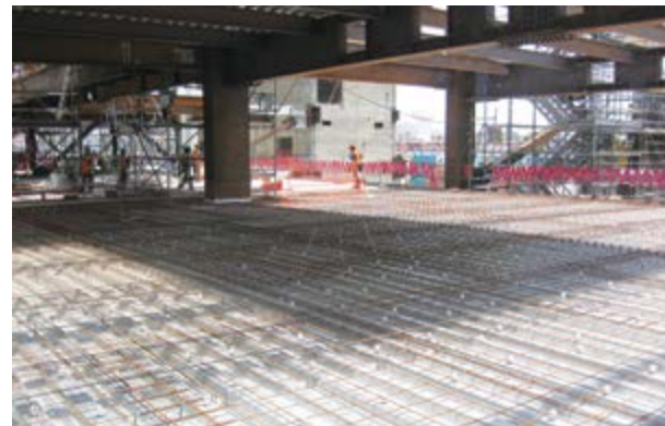
Encofrado - Sistema Constructivo Acero-Deck®
