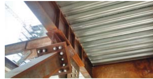
Detalle de estructura y Acero-Deck®
