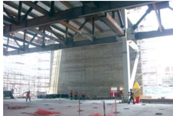
Elementos reticulares apoyados sobre columnas interiores con Placa colaborante Acero-Deck® y núcleos de concreto.
