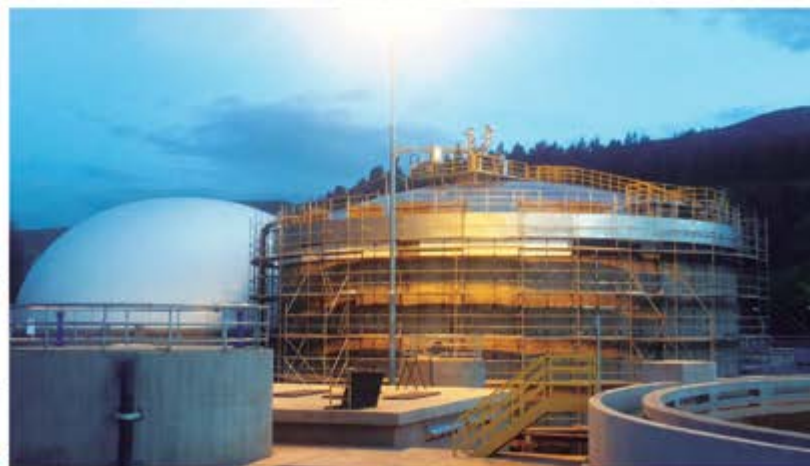
PLANTA DE TRATAMIENTO DE AGUAS RESIDUALES SAN JERÓNIMO
