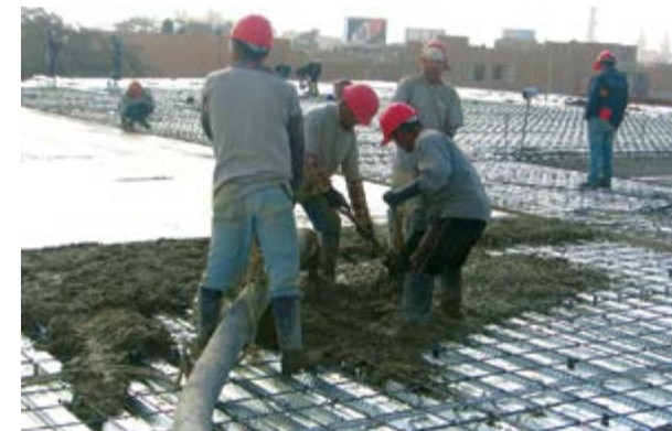
Vaciado de losa colaborante Acero-Deck®
