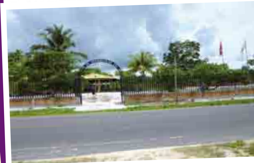
Cerco perimétrico del fundo del Ingeniero, Varillal Km 14.5 Carretera Iquitos-Nauta
