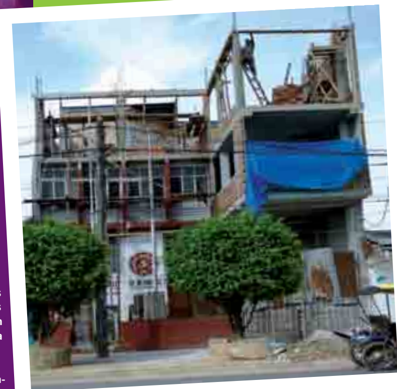
Remodelación del local del Consejo Departamental. Ampliación de dos niveles y mejoramiento de la fachada del local central del Consejo Departamental de Loreto. Área en construcción 230m 2 aproximadamente
