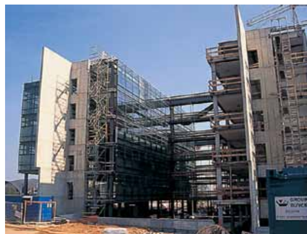
Proceso en Construcción
