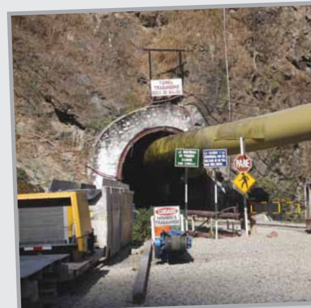
Túnel Trasandino del Proyecto Olmos
