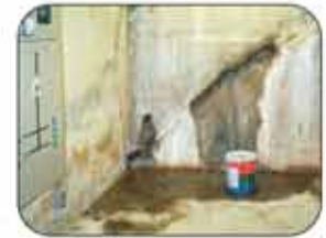
Etapa 2 Reparación de Estructura con Radmyx
