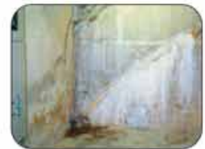
Etapa 3 Reparación Exitosa con Radmyx
