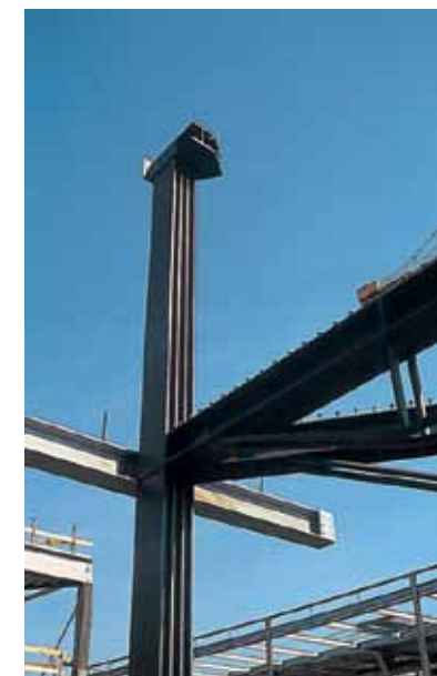
Detalle de Estructura
