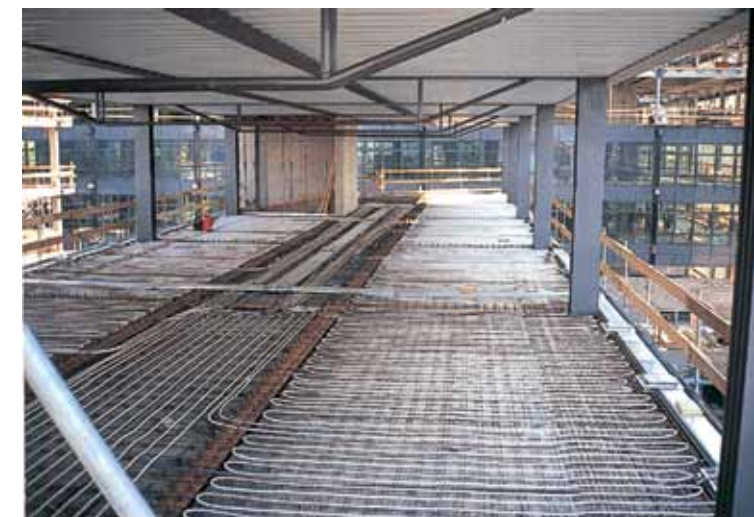
Sistema de Climatización Losa Colaborante / Agua
