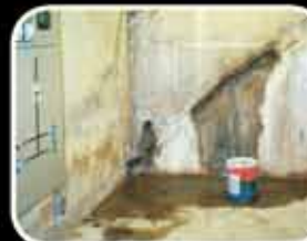
Etapa 2 Reparación de Estructura con Radmyx
