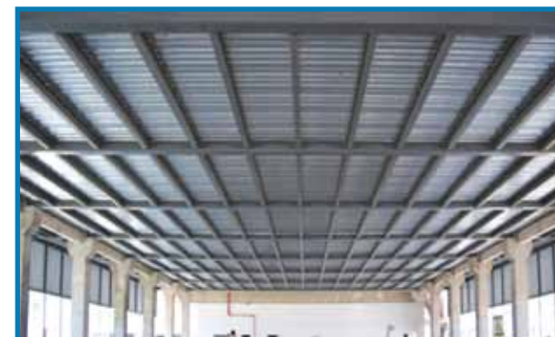
Obra: Planta Braun
