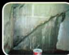
Etapa 1 Filtración de Agua
