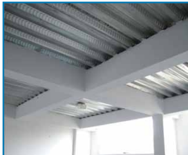
Vista inferior de una losa colaborante Acero-Deck® Obra: Colegio Howard Gardner
