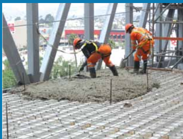
Vaciado de concreto de una losa colaborante Acero-Deck® Obra: Edificio Link Tower
