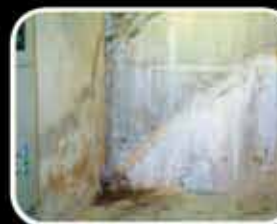
Etapa 3 Reparación Exitosa con Radmyx
