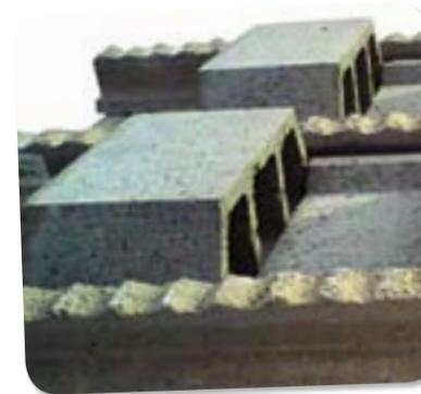
El sistema de viguetas pre tensadas Firth, dijo el ejecutivo, es una alternativa industrializada al sistema convencional de techos y entrepisos. Está constituida principalmente por dos elementos, la Vigueta Pretensada como elemento portante y las bovedillas.
