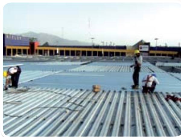
Instalación de Placa Colaborante.
