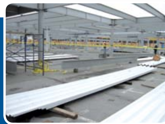
Proceso constructivo Acero Deck.
