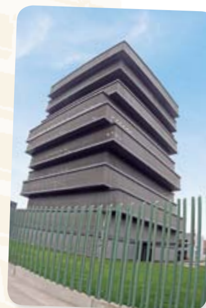
Edificio Torre Mayor: Más de 240 Tn. de Acero Dimensionado.
