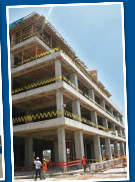
El Sistema Constructivo Acero Deck es fácil y rápido de instalar. Asimismo permite reducir el peso del sistema de vigas, columnas y cimentación.
