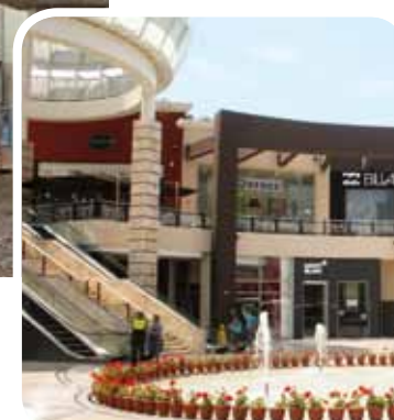
Boulevard Jockey Plaza: Más de 1,200 Tn. de Acero Dimensionado.
