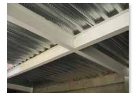
El Sistema Constructivo Acero Deck es fácil y rápido de instalar. Asimismo permite reducir el peso del sistema de vigas, columnas y cimentación.
