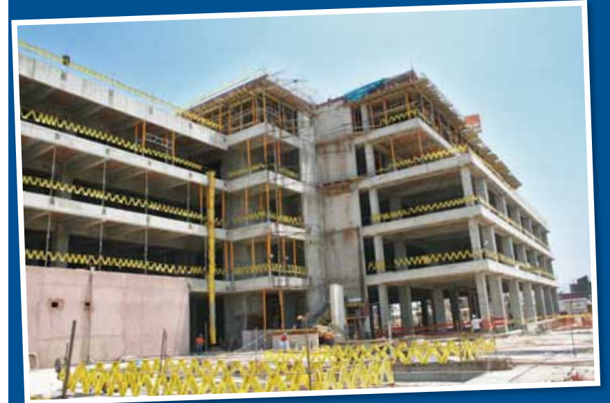
Este sistema permitió una construcción mixta, liviana y de gran resistencia en los niveles donde se ha utilizado en la nueva sede del Banco de Crédito del Perú de Chorrillos.
