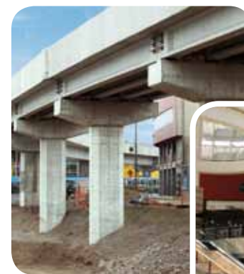
Tren Eléctrico: Más de 18,000 Tn. de Acero Dimensionado.
