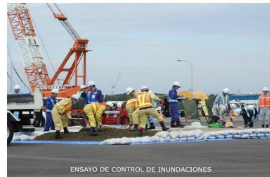
g) Simulación del cierre de boquetes de inundación con bolsas de arena.
