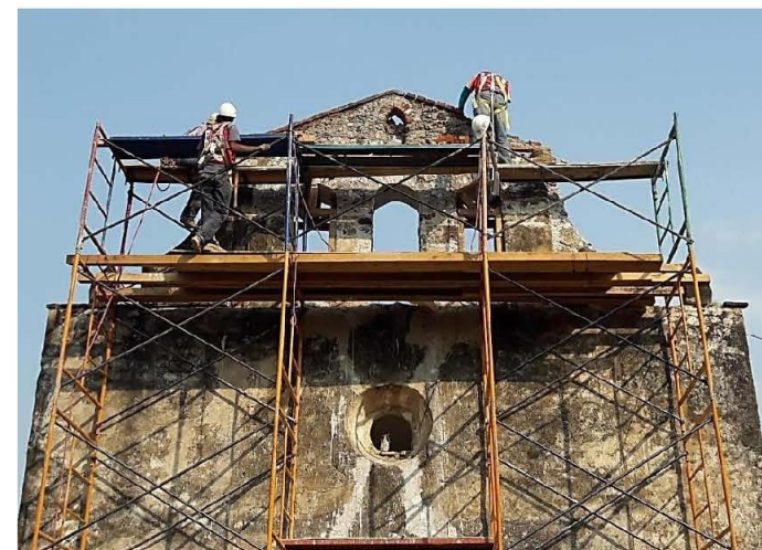
CAPILLA DE LA CONCEPCIÓN Restauración de fachada
