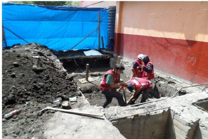
Escuela Secundaria No. 79 "República de Chile" Armado de estructuras para cimentación
