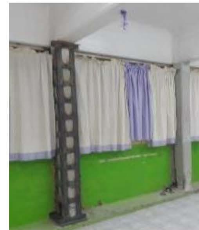
CENDI 26, Enrique Pestalozzi Reforzamiento de columnas en aulas
