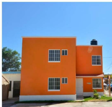
Viviendas terminadas, Jojutla Morelos
