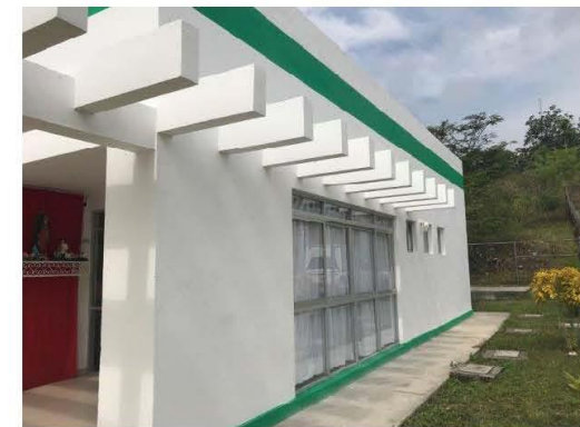
Reparaciones de fisuras en fachadas y trabajos terminados
