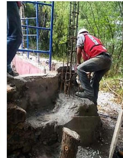
Jardín de Niños "Alfredo B. Nobel" Demolición para desplantes de castillos, reconstrucción de barda perimetral.
