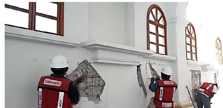
PARROQUIA DE SAN PEDRO APOSTOL Reparaciones
