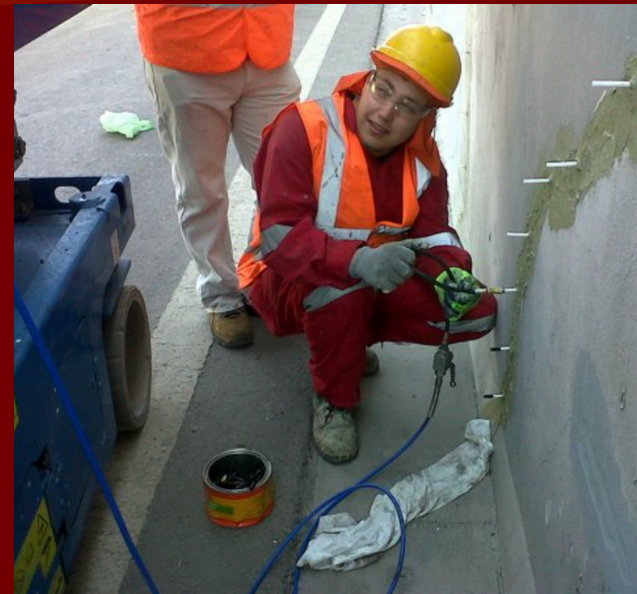
Inyección de resina epóxica en grietas.
