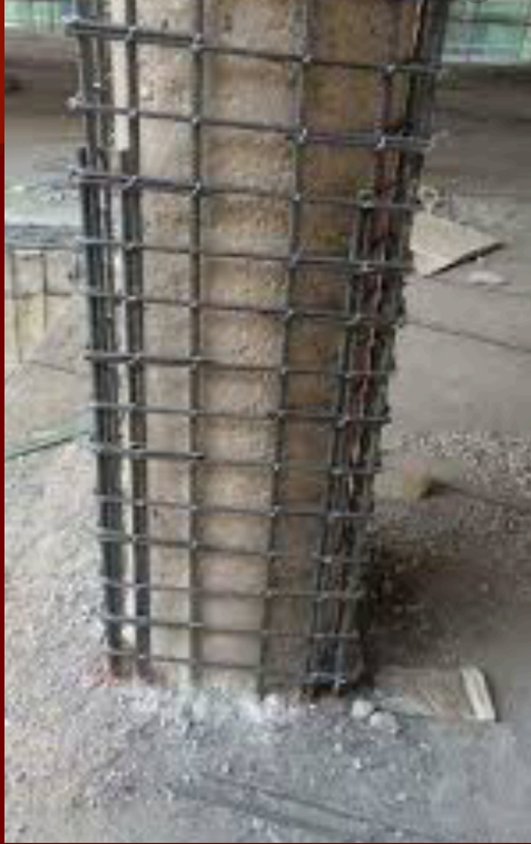
Encamisado de columna.
