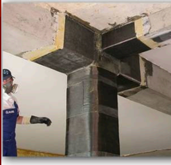
Reforzamiento de columna y viga con fibra de carbono.
