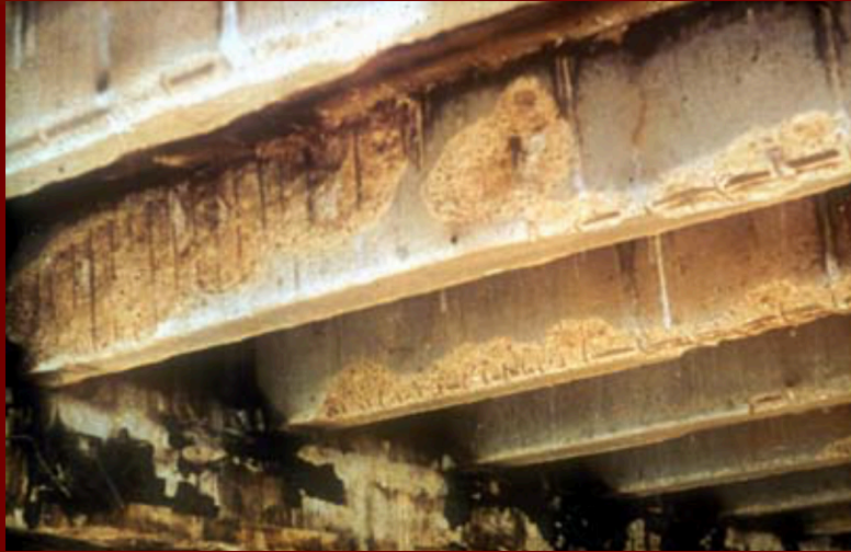
Vigas de concreto.
