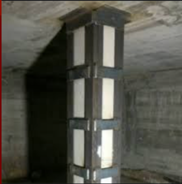
Encamisado de columna con perfiles metálicos.
