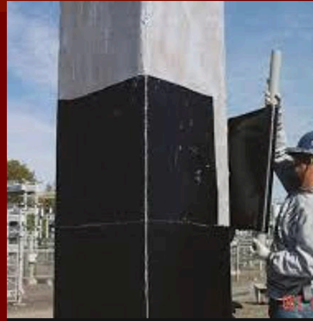
Reforzamiento de columna con fibra de carbono.
