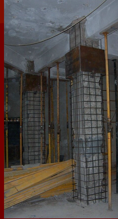
Encamisado de columna y collarín metálico.
