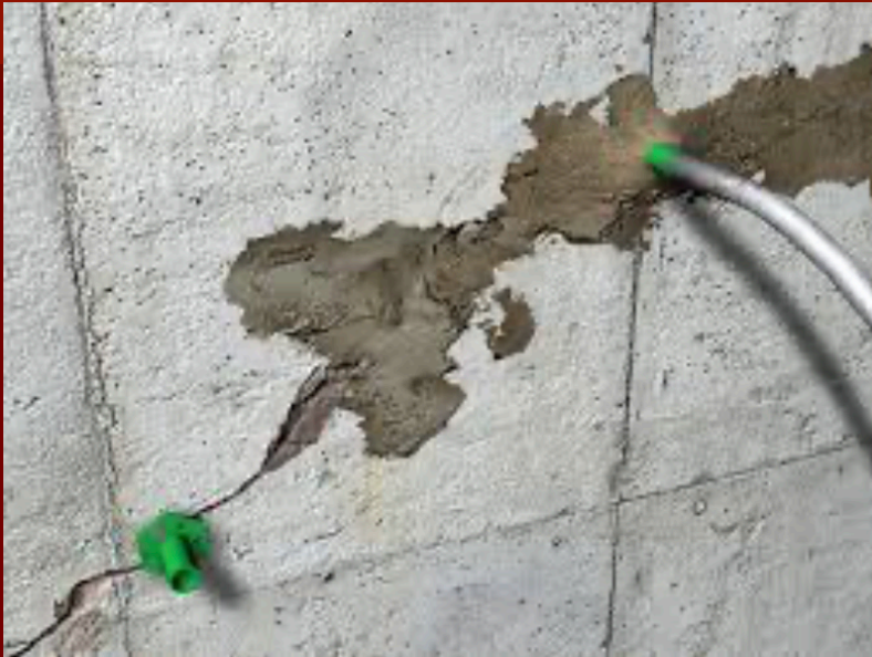
Inyección de resina epóxica en grietas.
