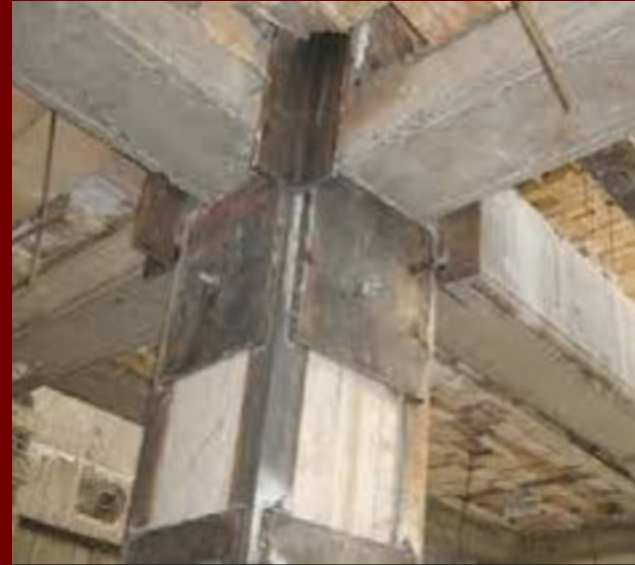
Encamisado de columna con perfiles y planchas metálicas.
