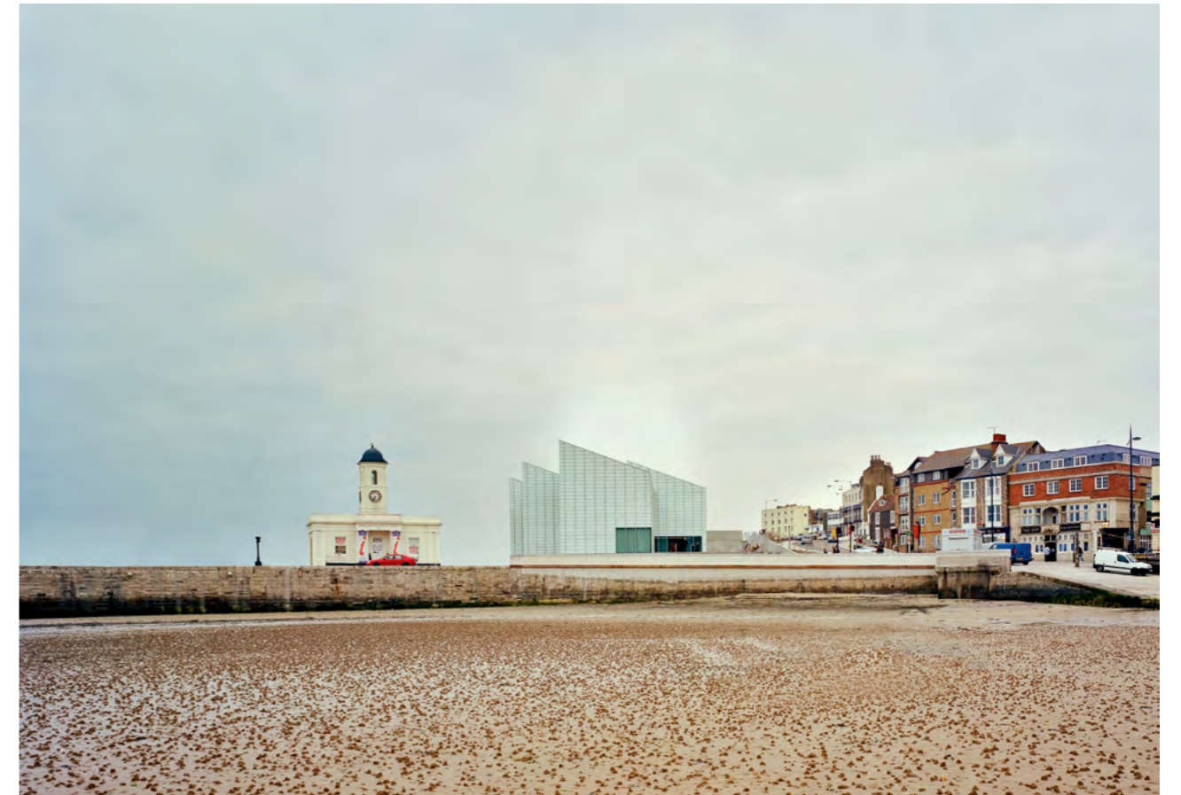
Los seis volúmenes idénticos que componen la Turner Contemporary Gallery (Margate, 2006-2013) están contruidos a partir de un armazón de hormigón y tienen una piel de vidrio grabada al ácido, con tejados a un agua para drenar la lluvia. Fotos de Simon Menges.
