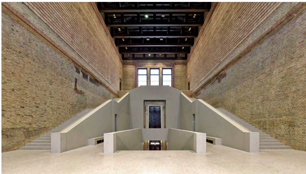
La restauración de The Neues Museum siguió las pautas de la Carta de Venecia, respetando lo que quedaba del edificio en sus diferentes estados de conservación. Todos los espacios de la estructura existente se rellenaron sin competir con esta, en términos de brillo y superficie. Así, lo nuevo refleja lo perdido, sin imitarlo. El museo volvió a abrir sus puertas en 2009, tras permanecer más de sesenta años en ruinas. Fotos de Joerg von Bruchhausen y Ute Zscharnt.
