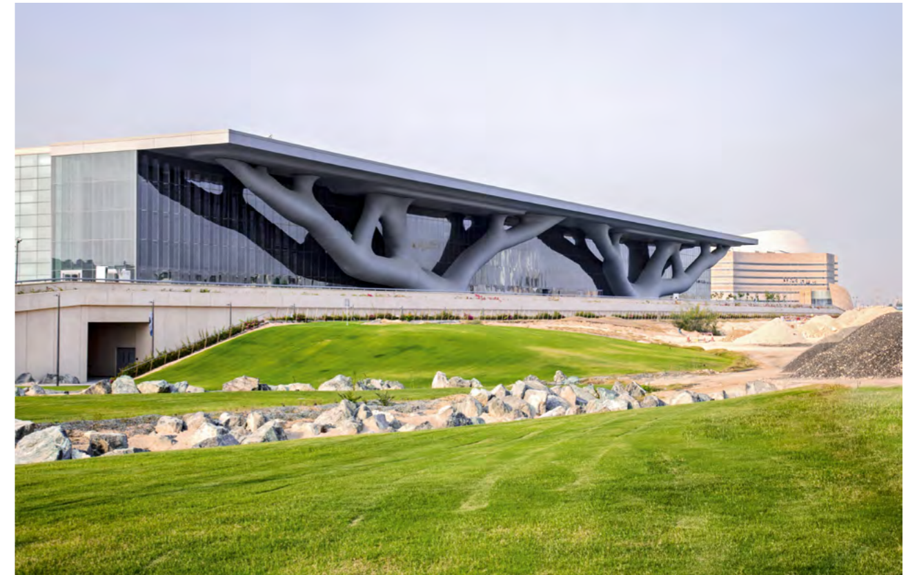
El escultórico exterior del Centro Nacional de Convenciones de Qatar (Doha, 2004-2011) alude al árbol sagrado de la cultura islámica: el Sidrat al-Muntaha, que simboliza el final del séptimo cielo. El edificio ha logrado resultados ejemplares en términos de sostenibilidad. Foto de Hisao Suzuki.
