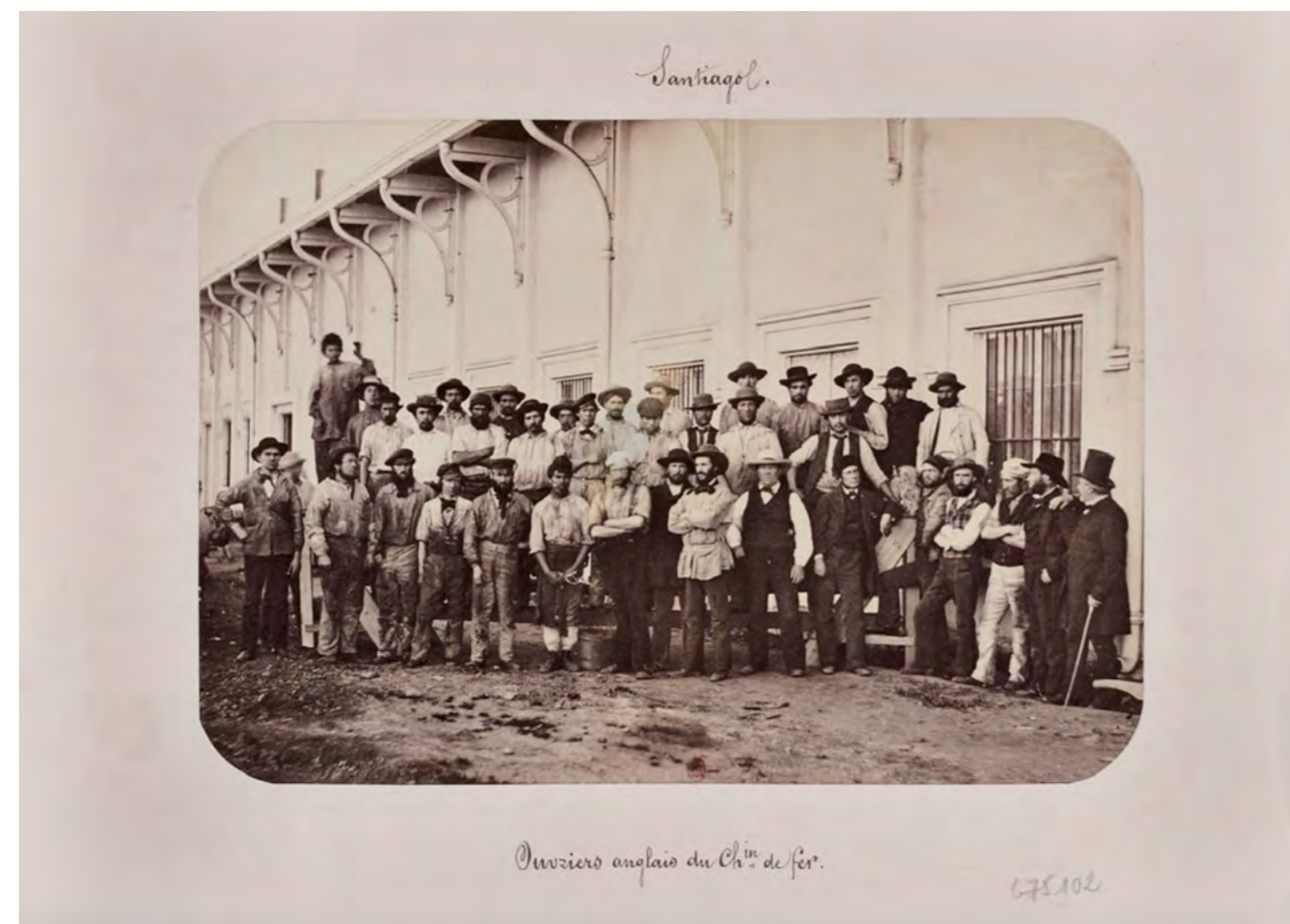
Obreros ingleses que trabajaban con Meiggs
