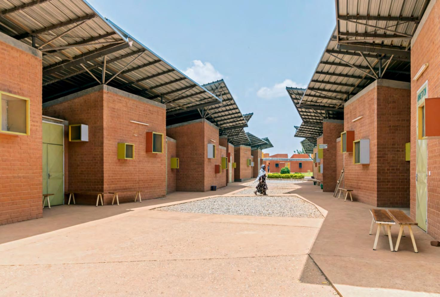
La clínica de Léo (2014) se compone de varias unidades modulares, fabricadas con materiales autóctonos, que ofrecen servicios quirúrgicos, de maternidad y de hospitalización. El diseño destaca por amplios techos superpuestos y ventanas que se adaptan a diferentes puntos de vista. Foto: cortesía de Francis Kéré.
