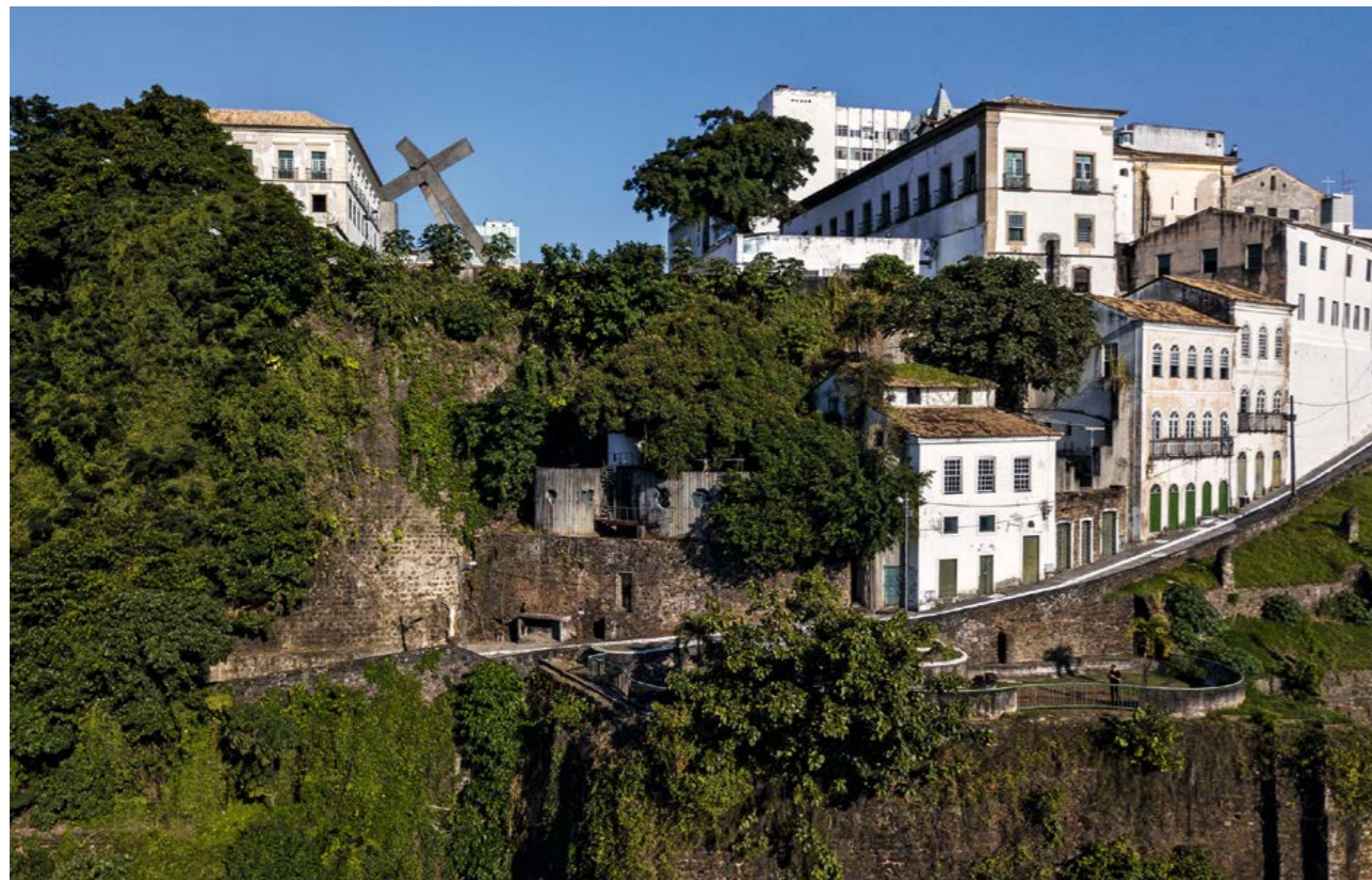
El proyecto de Ladeira da Misericórdia (1987-1988) fue concebido para encontrar soluciones a la degradación de los edificios de esta zona de Salvador de Bahía. Aquí Bo Bardi desarrolló un sistema modular de ferrocemento capaz de estabilizar la antigua estructura y, a la vez, soportar las nuevas piezas. Foto de Leonardo Finotti.
