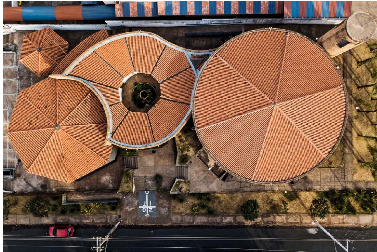
Iglesia del Espírito Santo do Cerrado (1976-1982). La austeridad de los monjes franciscanos que le encargaron el proyecto no impidió que la arquitecta encontrara soluciones creativas: el hormigón se limitó a las partes esenciales de la estructura. El resto se construyó con materiales reutilizados. Foto de Leonardo Finotti.
