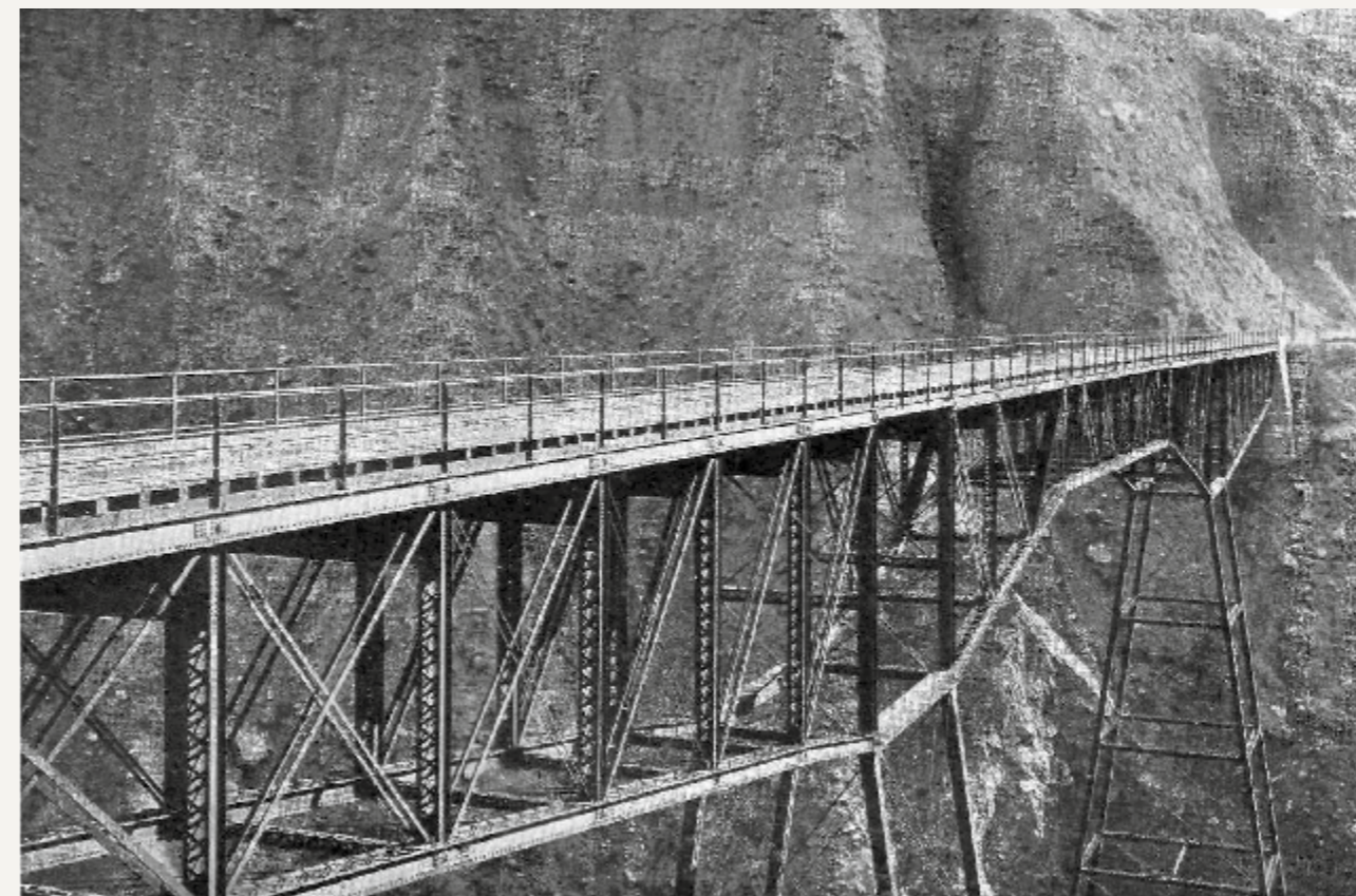
El Puente Verrugas reconstruido en 1921.
