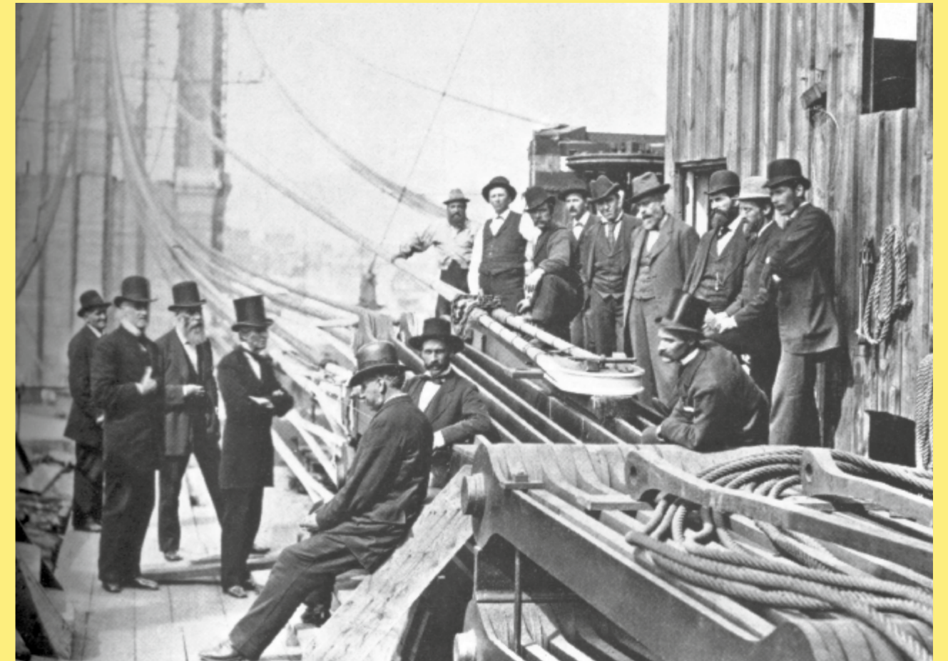
En plena construcción del puente Brooklyn.
