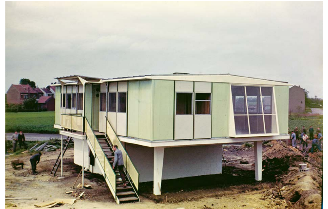
La Maison Métropole, construida en Tourcoing, hacia 1952. Fabricada en aluminio, esta iniciativa del Ministerio de Reconstrucción y Urbanismo formó parte de una serie de viviendas parcialmente ensambladas en la fábrica y destinadas a construirse en ultramar. © Jean Prouvé, VEGAP, Barcelona, 2021.
