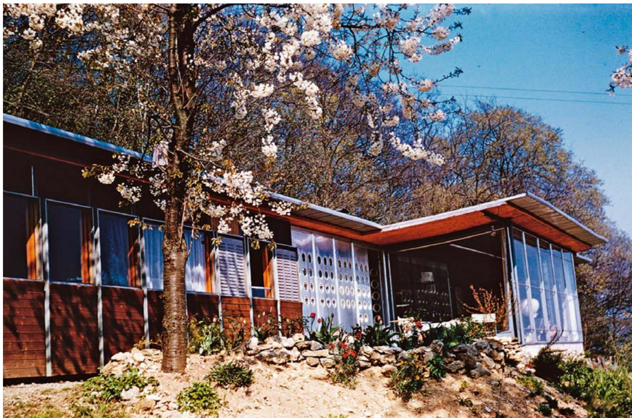
Casa de la familia Prouvé en Nancy (1954). La cubierta, autoportante y sin vigas, es ligeramente curvada para poder sostener su peso. Los paneles de aluminio de la fachada tienen una medida inusual para la época: un metro de ancho. © Jean Prouvé, VEGAP, Barcelona, 2021.
