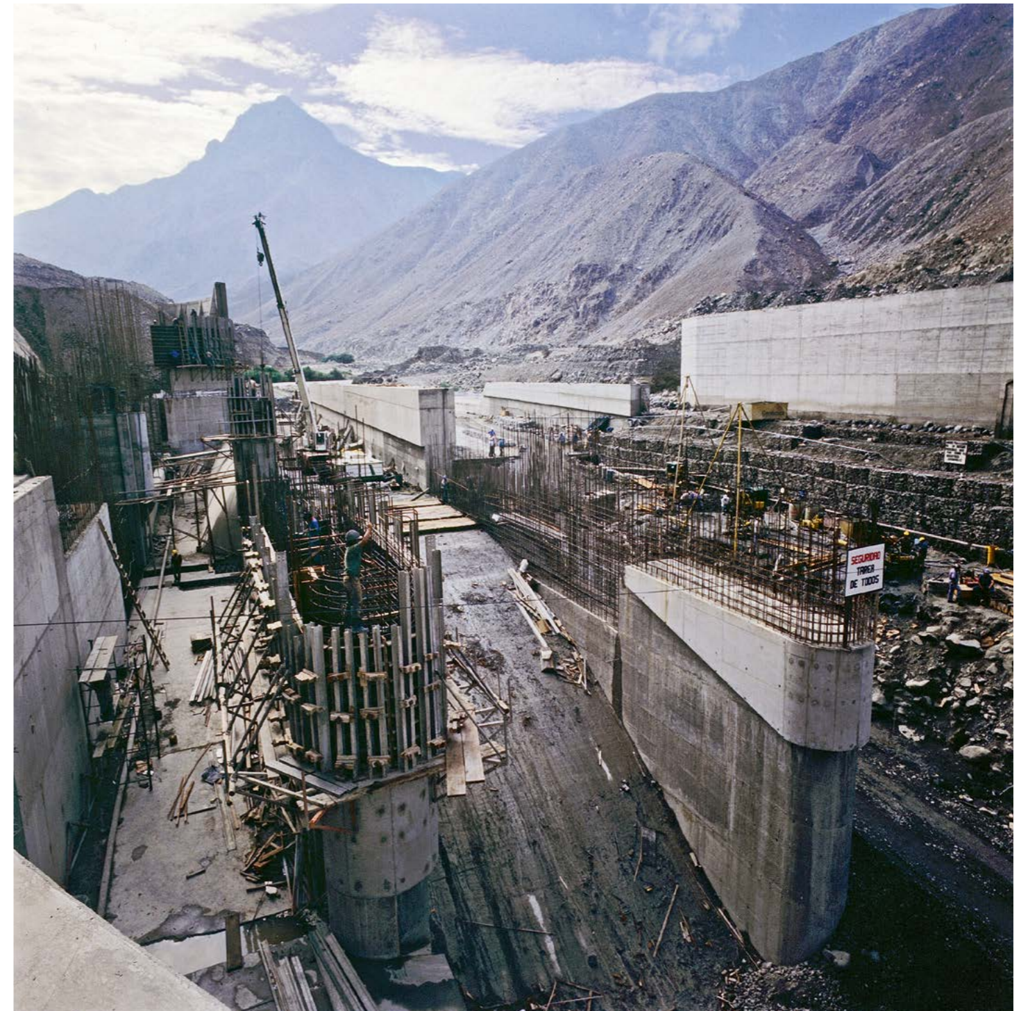
Construcción de bocatoma para derivar agua del río Santa a Chavimochic
