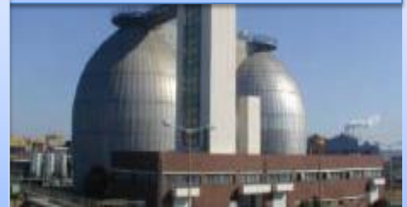
Tanque de Almacenamiento de Biogás
