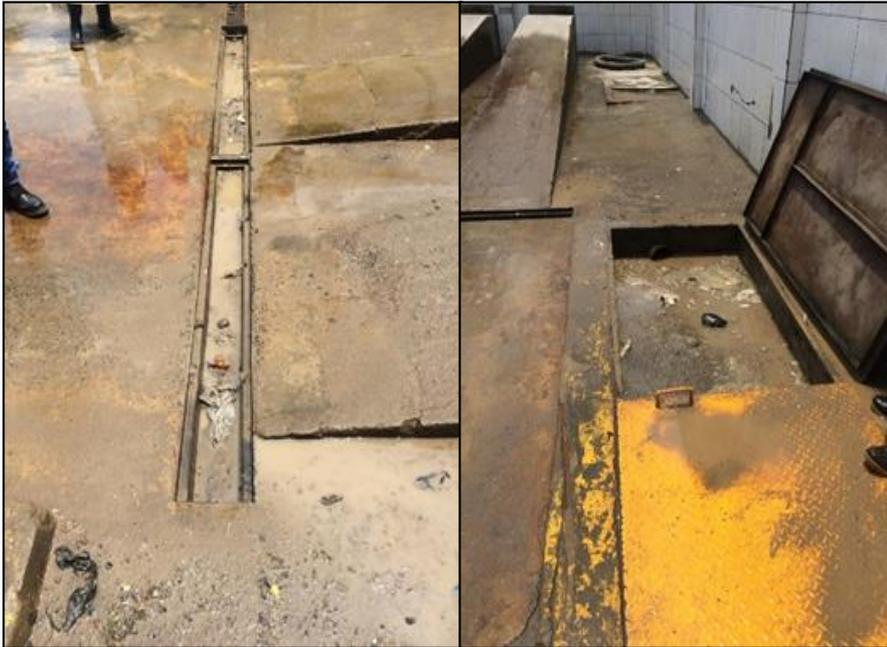
El área de lavado, cuenta con el canal o trampa obstruido con lodo y residuos sólidos. El contenido del pozo séptico, se encuentra a un nivel de inadecuado.
