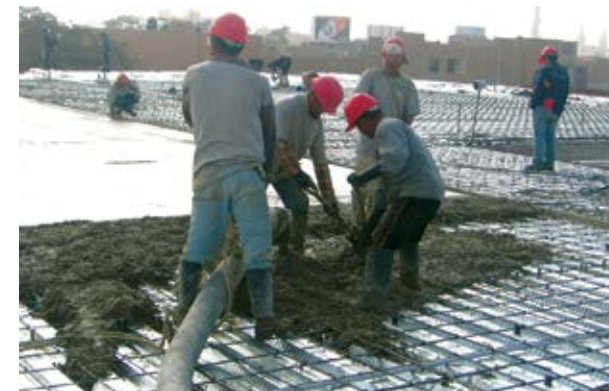
Vaciado de losa colaborante Acero-Deck®
