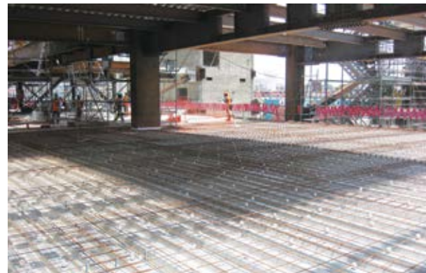
Encofrado - Sistema Constructivo Acero-Deck®
