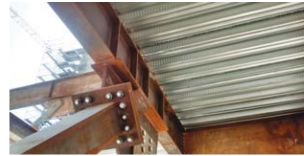
Detalle de estructura y Acero-Deck®
