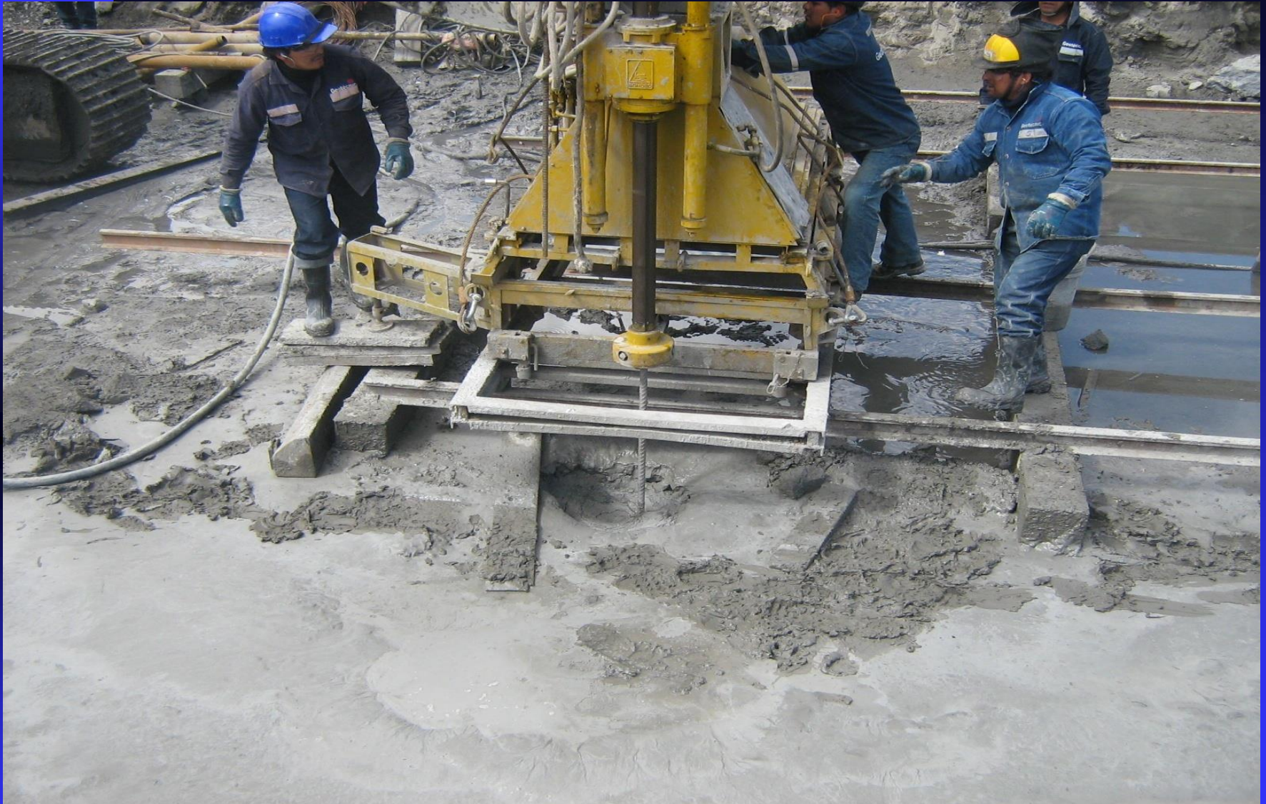
INSTALACION DE COLUMNA JET GROUTING
