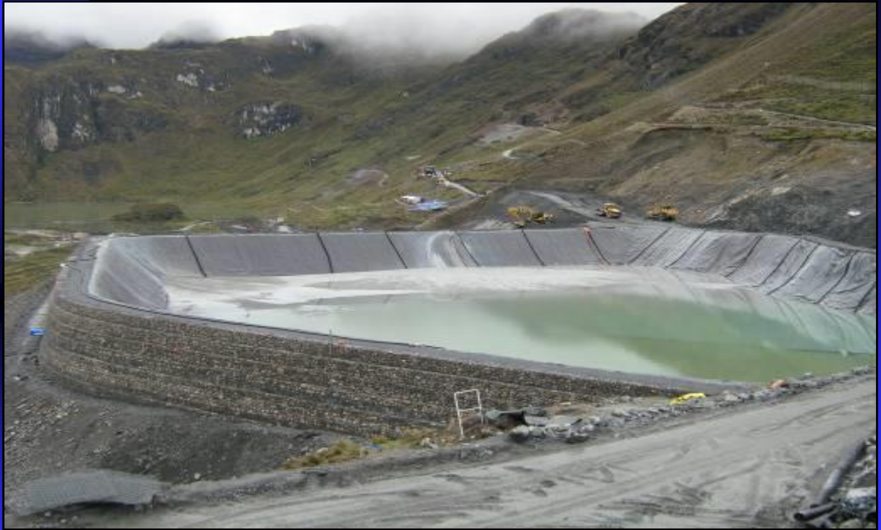
DEPOSITO DE RELAVES EN OPERACION
