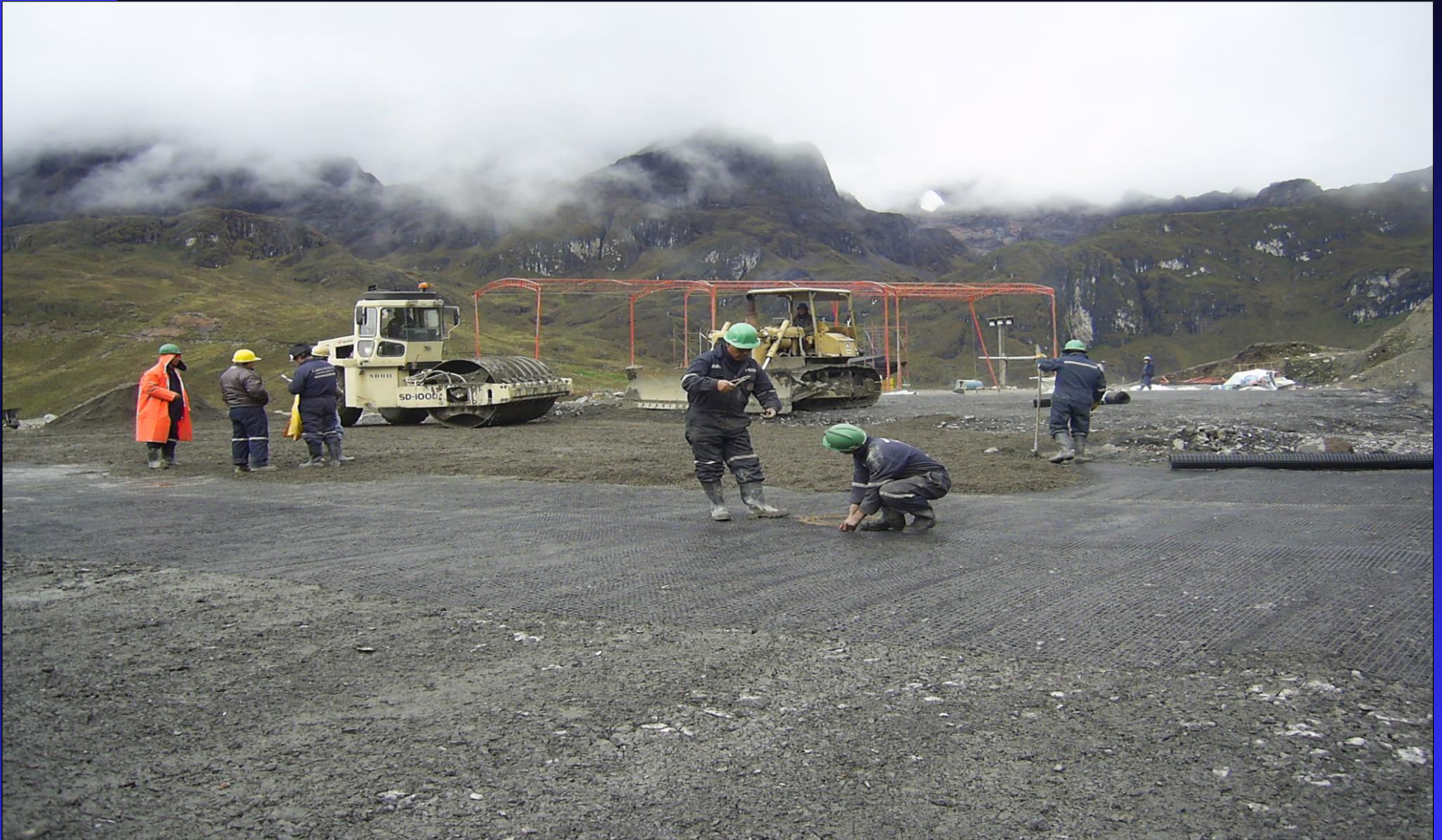
INSTALACION DE GEOMALLA UNIAXIAL EN LA BASE DEL TERRAPLEN DE LA PRESA
